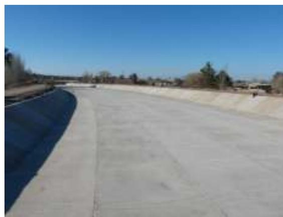
*Impermeabilización del Canal Principal de Riego*
